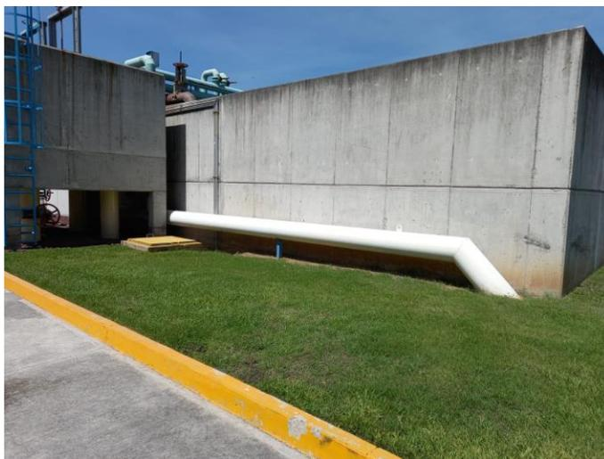
*Ilustración 17 Tubería de Aire Remplazada*
