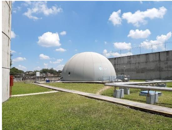
*Ilustración 23 Tanque de Almacenamiento de Biogás*
