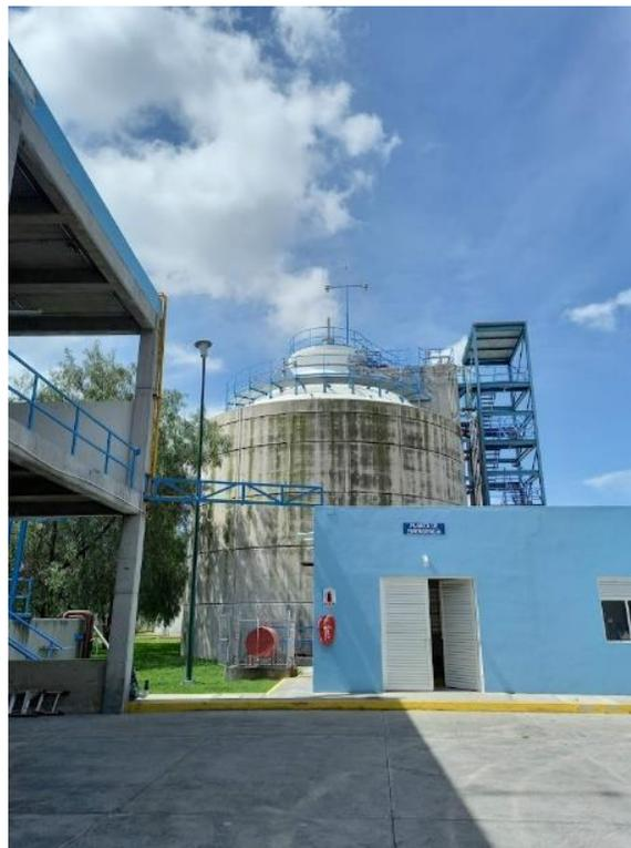
*Ilustración 20 Digestor con Recubrimiento Aplicado*
