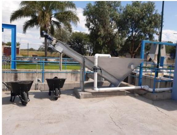
*Ilustración 16 Lavador de Arena Rehabilitado*
