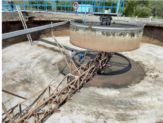
*Ilustración 19 Clarificador Secundario Vacío*
