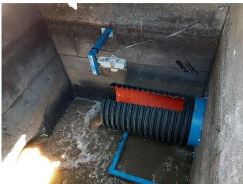
*Ilustración 10 Medidor FloDar Instalado*
