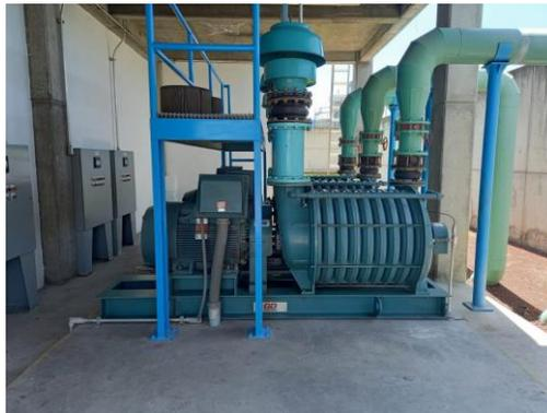
*Ilustración 21 Sopladores Centrifugos Instalados*
